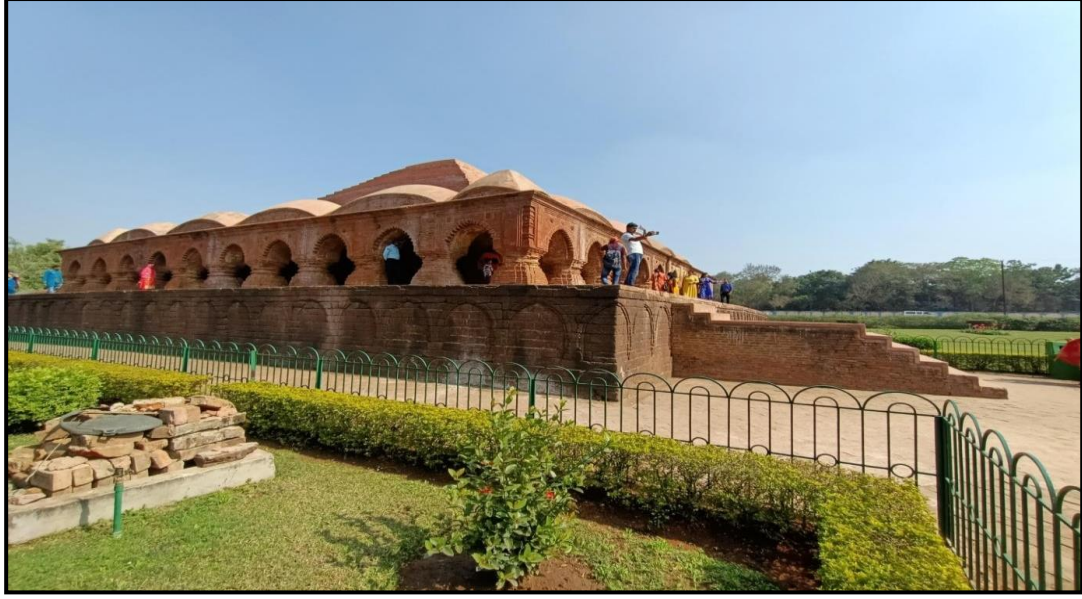
चित्र 3, दक्षिण-पश्चिम ओर से लिया गया व्यापक दृश्य Figure 3, general view from south-east.
